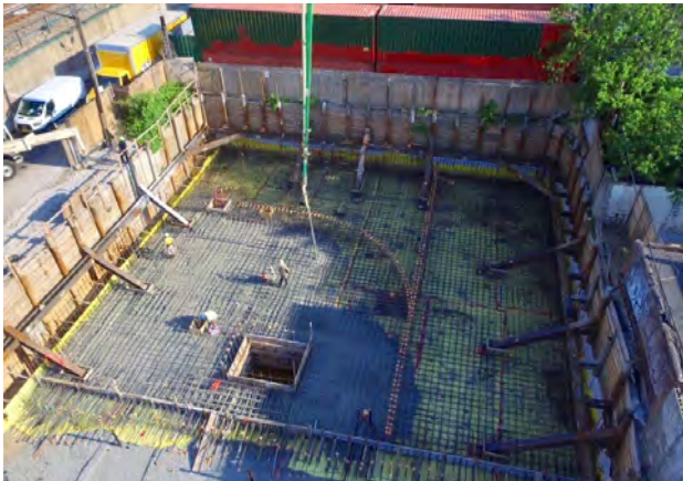
VAN SINDERIN EXCAVATION
